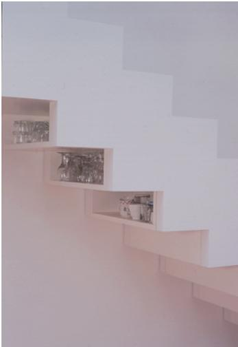
Regalfächer auf der Unterseite, Klappfächer auf der Oberseite der Treppe – die Konstruktion ist ausgetüfelt, aber, wie die Details zeigen, nicht allzu kompliziert.
