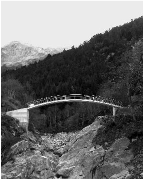
Passerelle SOJ im Val Soj im Tessin CH, 2006
